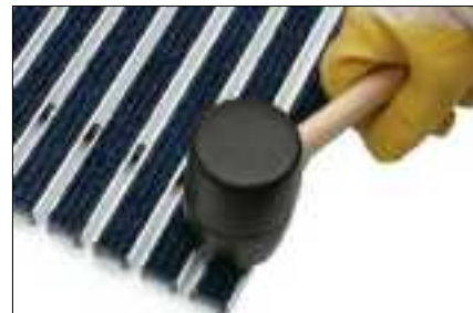
Positionner la nouvelle bande reps après avoir collé le ruban adhésif double face sur le profilé. Terminer la mise en place à l'aide d'un maillet caoutchouc pour bien plaquer l'insert reps dans la cavité du profilé.
